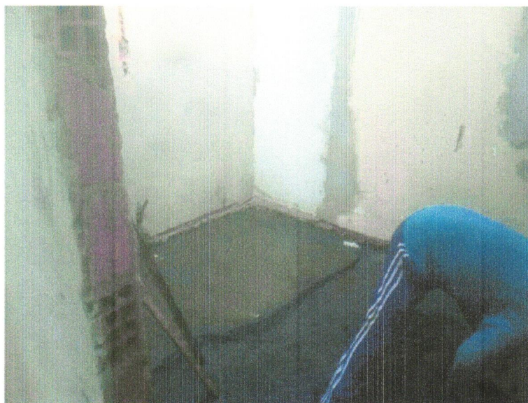
Foto 17- contrapiso em argamassa traço 1:4 (cimento e areia), preparo mecânico com betoneira 400l, aplicado em áreas secas sobre laje, não aderido, acabamento não reforçado, espessura 5cm. Af_07/2021
