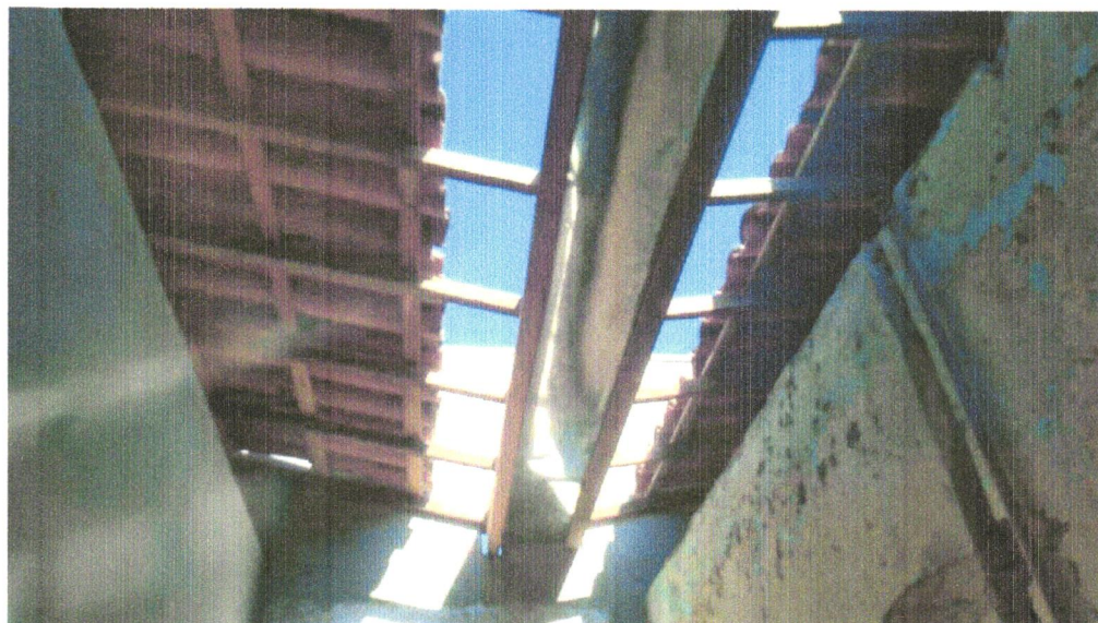
Foto 28 - CALHA EM CHAPA DE AÇO GALVANIZADO NÚMERO 24, DESENVOLVIMENTO DE 33 CM, INCLUSO TRANSPORTE VERTICAL. AF 07/2019
