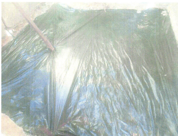
Foto 23 - APLICAÇÃO DE LONA PLÁSTICA PARA EXECUÇÃO DE PAVIMENTOS DE CONCRETO. AF_04/2022
