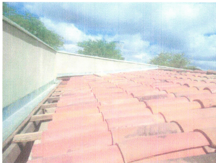
Foto 26- Rufo em chapa aço galvanizado nº24 com desenvolvimento 25cm
