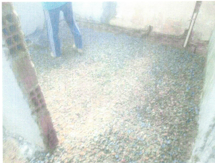
FOTO 04 - Lastro de brita graduada apiloada e=10cm
