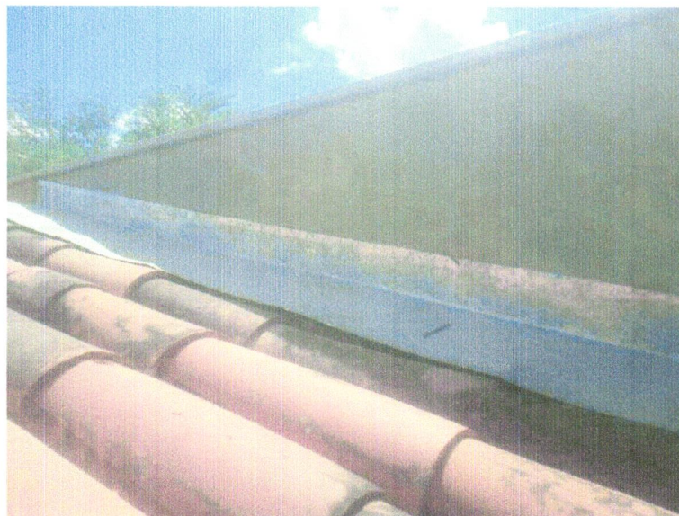
Foto 27 - Rufo em chapa aço galvanizado nº24 com desenvolvimento 25cm
