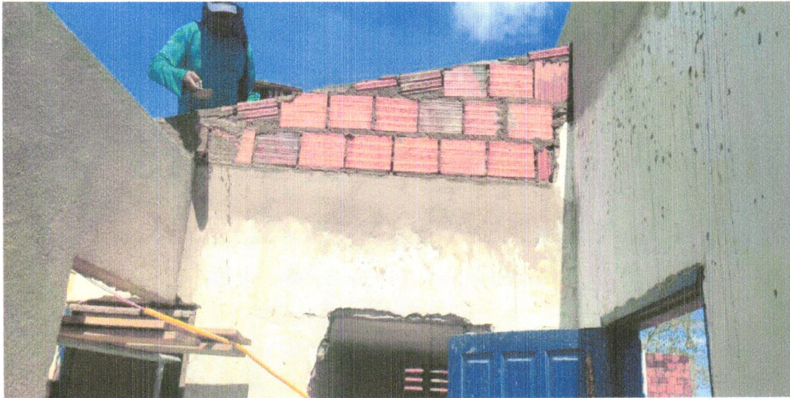
FOTO 03 -ALVENARIA DE VEDAÇÃO DE BLOCOS CERÂMICOS FURADOS NA HORIZONTAL DE 9X19X29 CM (ESPESSURA 9 CM) E ARGAMASSA DE ASSENTAMENTO COM PREPARO EM BETONEIRA. AF_12/2021
