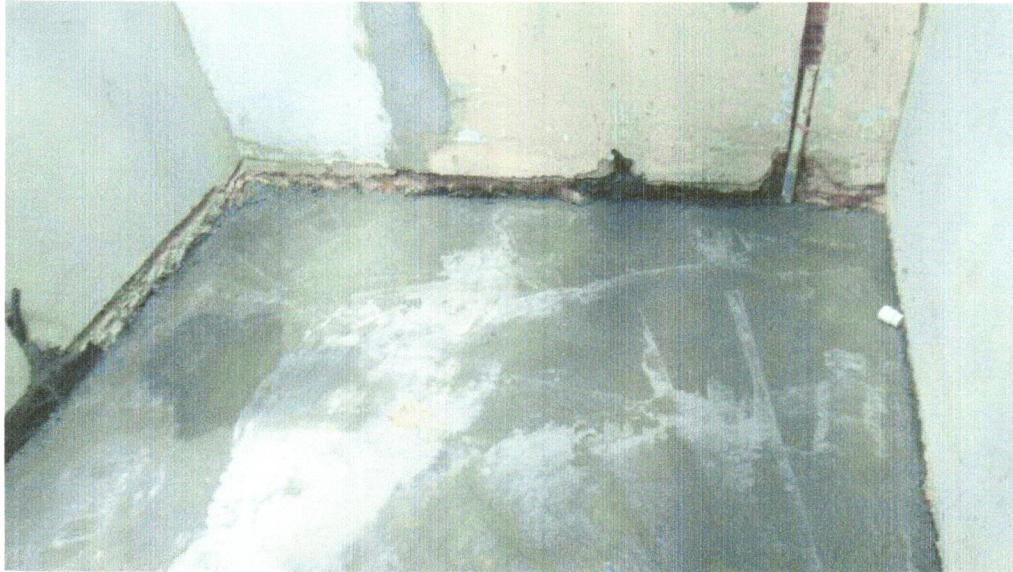
FOTO 13- PISO EM CONCRETO 20 MPA PREPARO MECÂNICO, ESPESSURA 7CM. AF_09/2020
