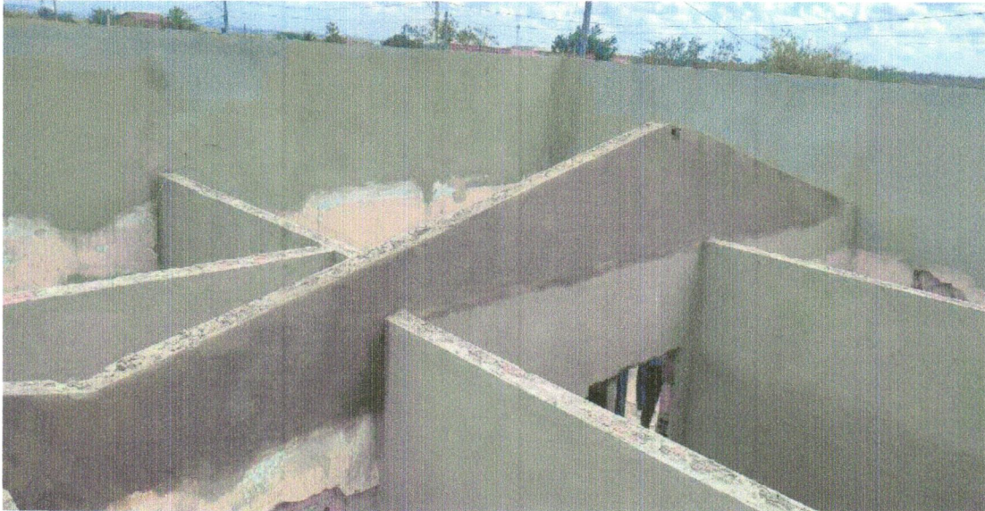
Foto 25 - MASSA ÚNICA, PARA RECEBIMENTO DE PINTURA OU CERÂMICA, ARGAMASSA INDUSTRIALIZADA, PREPARO MECÂNICO, APLICADO COM EQUIPAMENTO DE MISTURA E PROJEÇÃO DE 1,5 M 3 /H EM FACES INTERNAS DE PAREDES, ESPESSURA DE 5MM, SEM EXECUÇÃO DE TALISCAS. AF_06/2014
